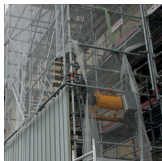
△ Manipulación de una escalera de crinolina.
