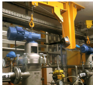
▶ Elevación de una bomba.
